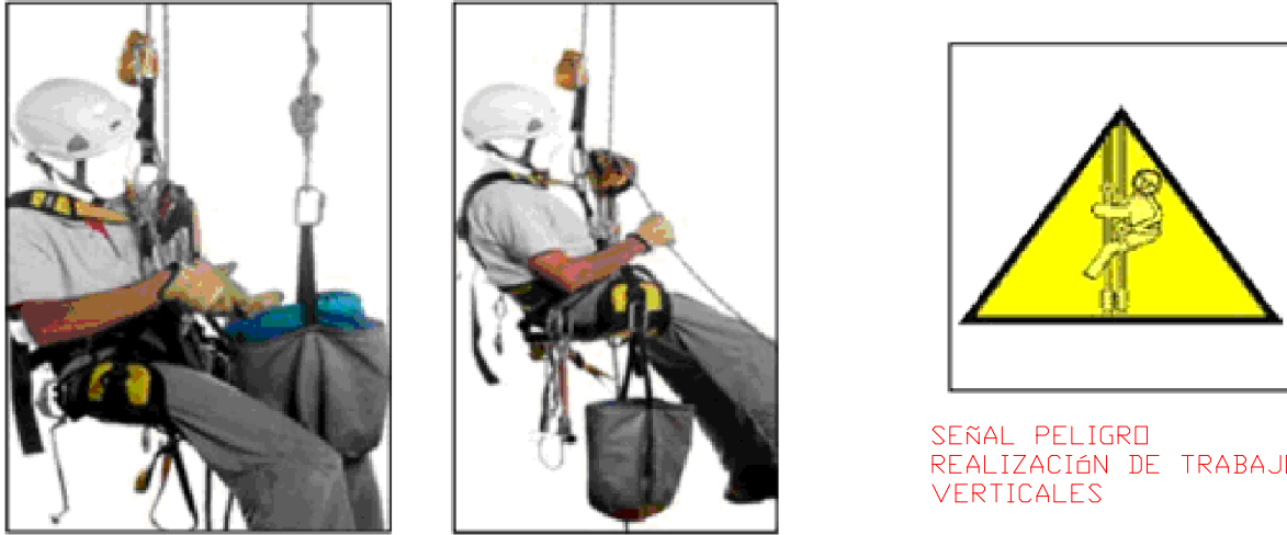
ABASTECIMIENTO ASISTIDO CON CUERDA AUXILIAR CESTA PORTAHERRAMIENTAS
